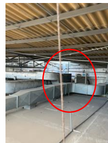
Soportes de apoyo de las bases de la unidad evaporadora y booster, se encuentran corroídos, se recomienda proyectar el cambio de la base de ambos equipos (Después del Mantenimiento)
