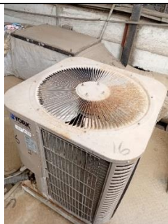
Unidad Condensadora (Antes del Mantenimiento)
