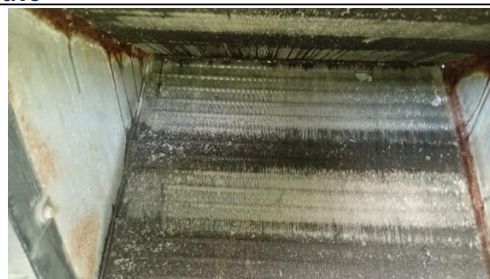
Serpentín Unidad Evaporadora (Antes del Mantenimiento)
